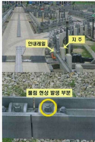
부산지하철노조가 23일 공개한 부산도시철도 4호선(무인경전철)의 이음매볼트 무실시공 현장. 노조는 경전철 탈선을 막기 위한 안내레일(사진 위)이 열차바퀴와 마찰하면서 이음매볼트가 풀리는 현상이 발생했다고 주장했다. | 부산지하철노조 제공
